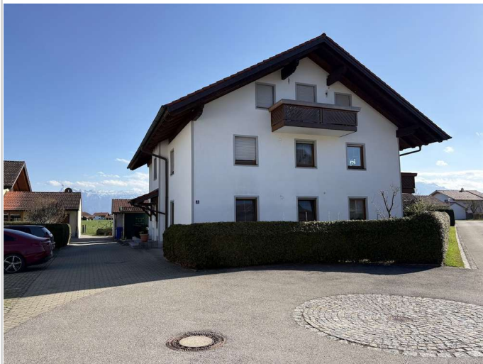
Außenansicht m. Zufahrt
